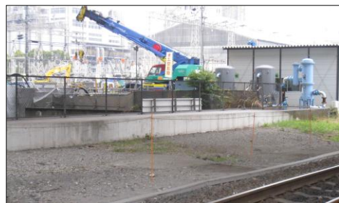
大規模な橋脚下部工事
