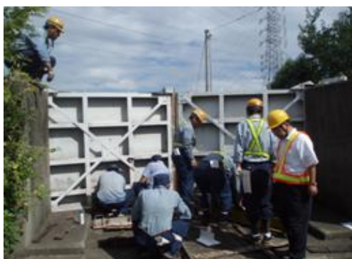
防潮堤扉取扱訓練の様子
